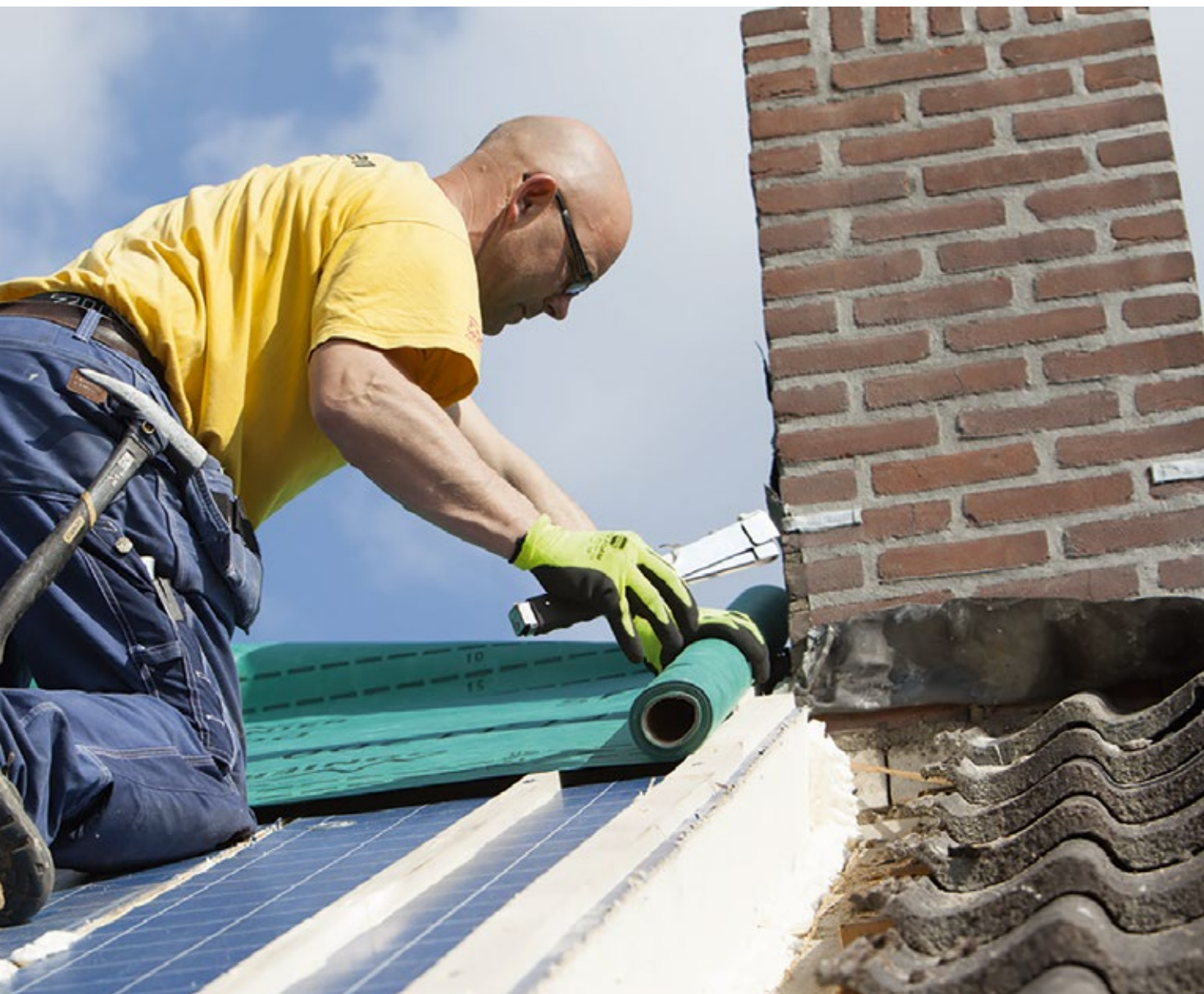
De daken van de woningen werden geïsoleerd met sandwichpanelen van Unilin.
