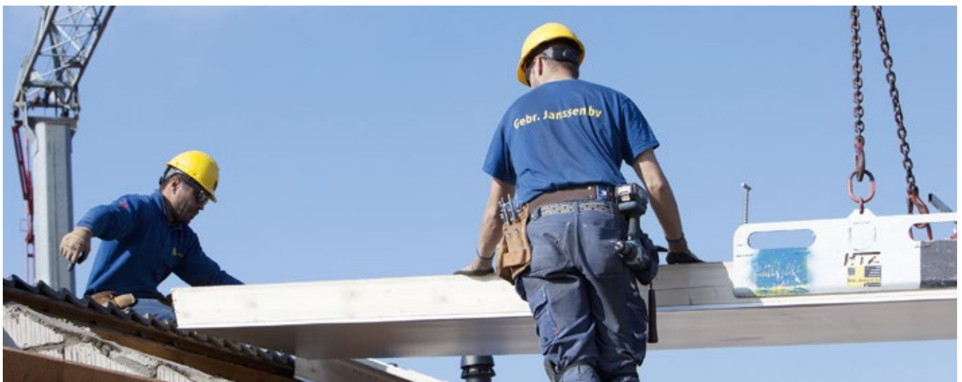
Aannemersbedrijf Gebr. Janssen uit Beugen is betrokken bij de renovatie van circa vierduizend woningen voor woningbouwvereniging Wonen Limburg.
