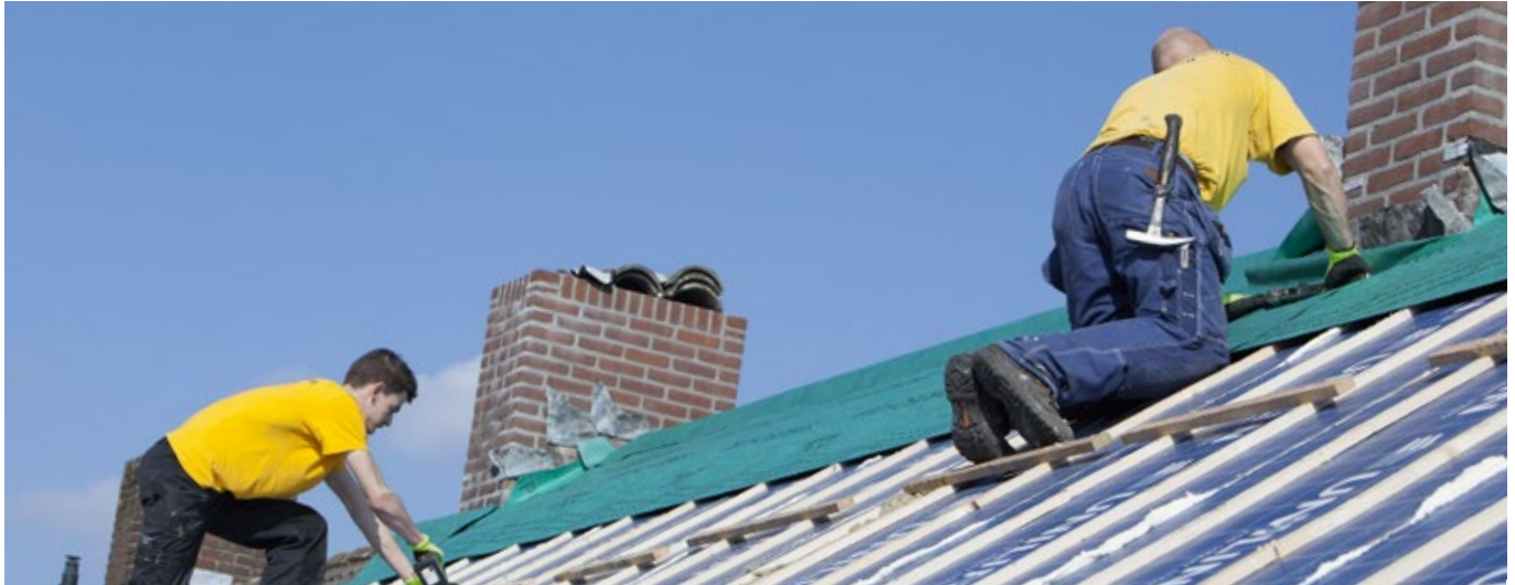
De isolatie moet de woningen naar een energielabel A of hoger brengen.
